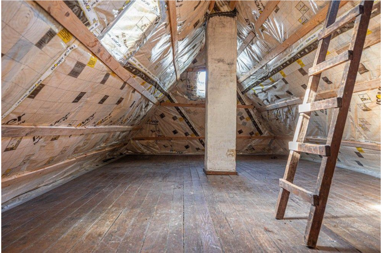
der geräumige Dachboden
