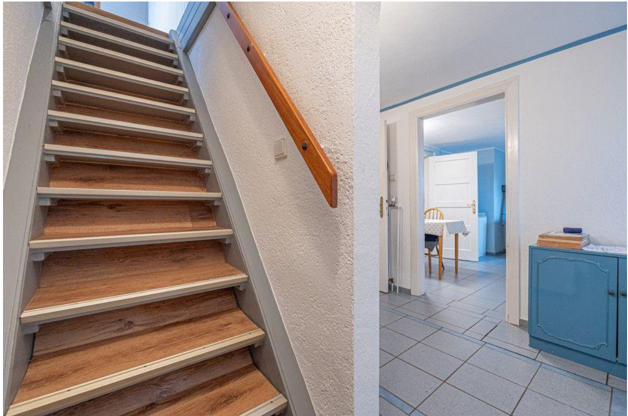
Treppe ins DG
