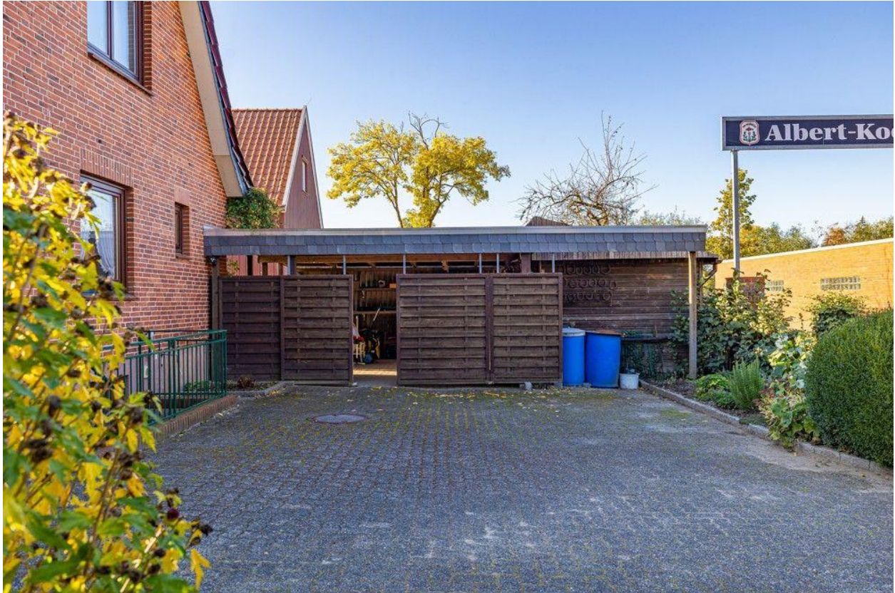
Carport mit Abstellraum/Werkstatt
