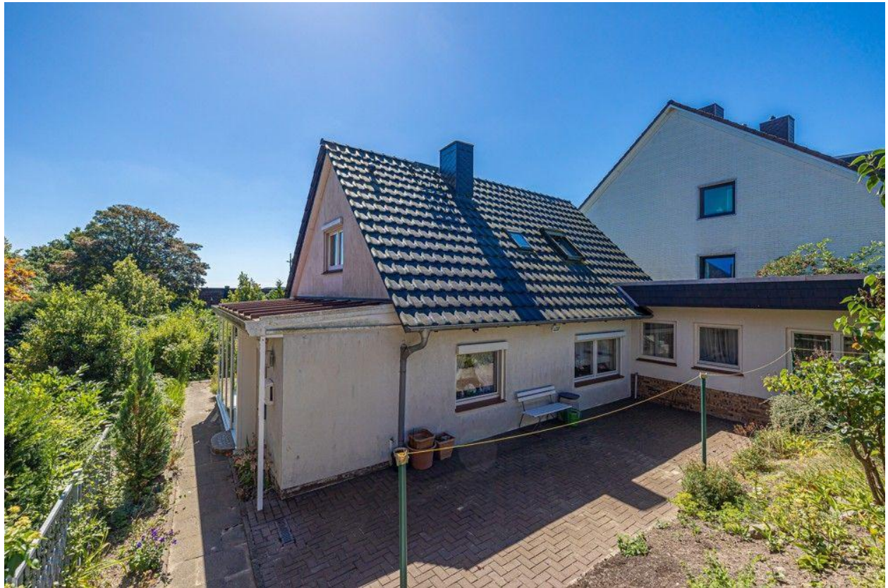
Blick vom Vorgarten auf das Haus und Nebengebäude
