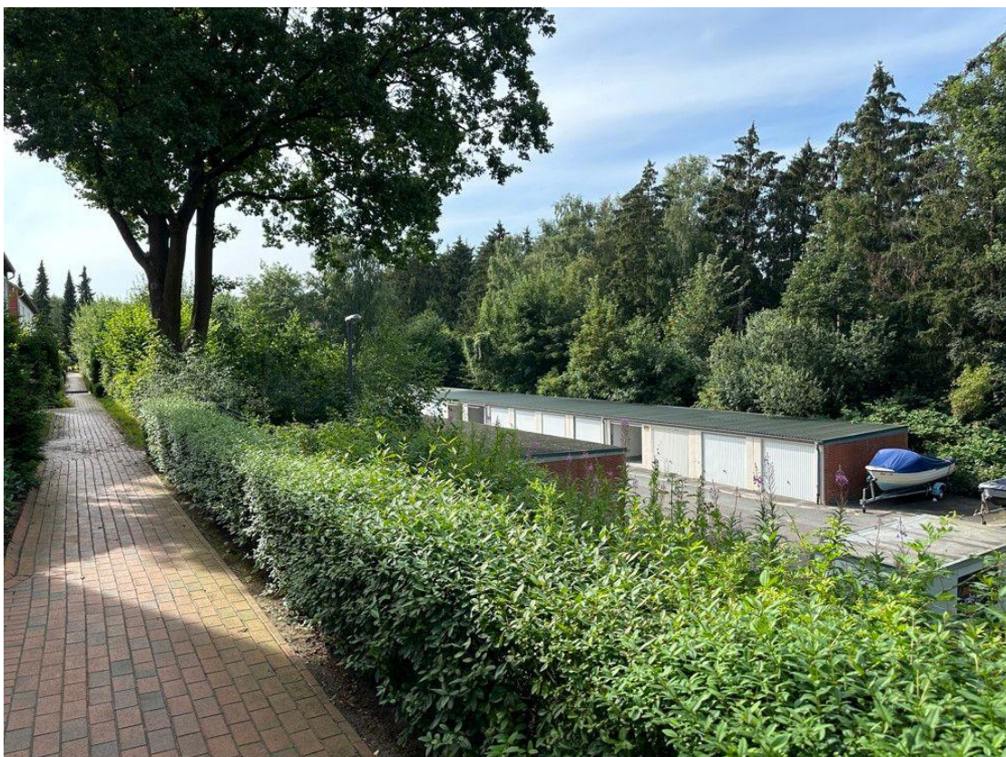
Garagenhof hinter dem Haus
