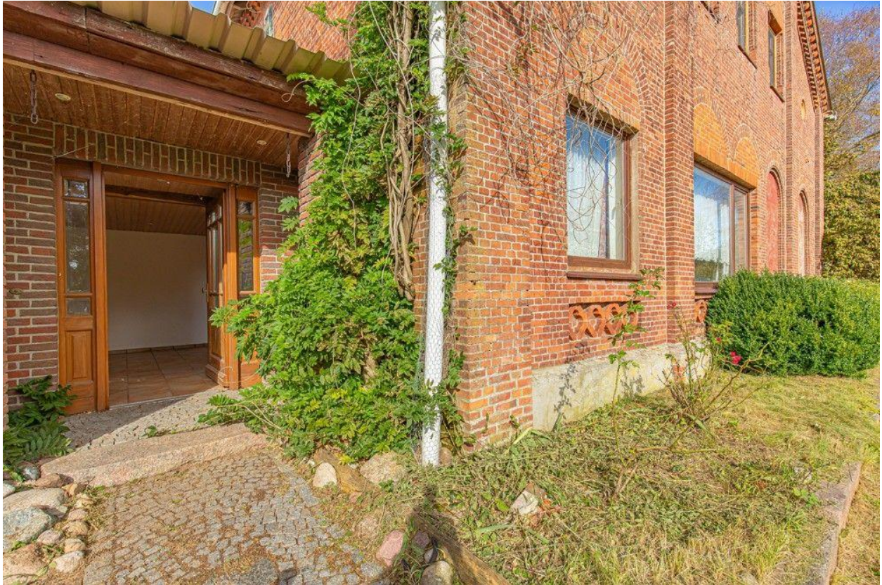
Eingang Wohnung OG
